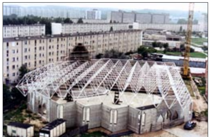
Unikatowa konstrukcja dachu naszego kościoła
