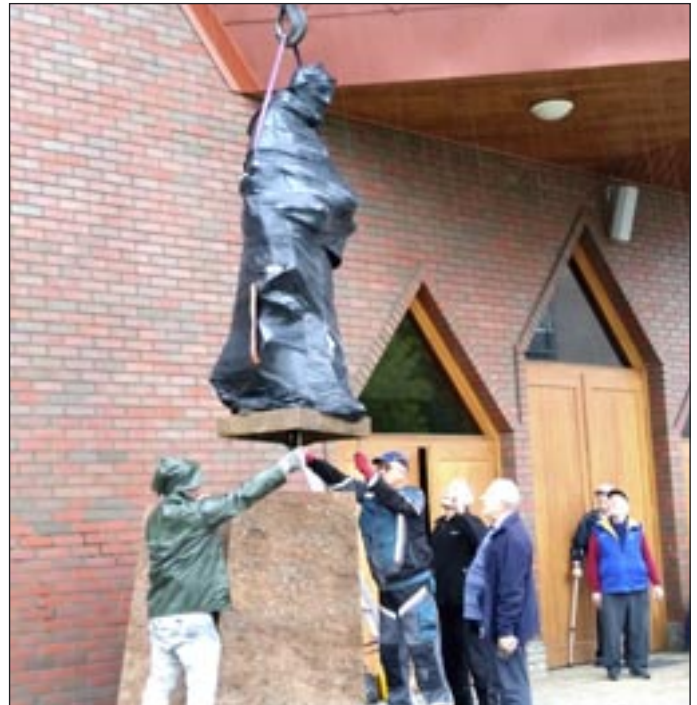
Montaż pomnika św. Brata Alberta
