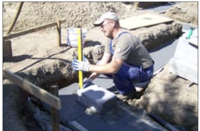
Szef budowy ogrodzenia i kiosku – pan Rafał Majkowski
