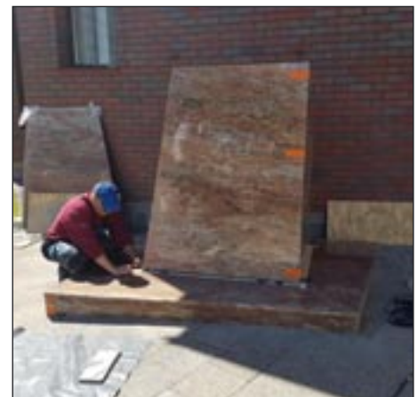
okładanie cokołu granitem
