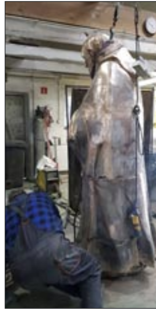
spawanie odlanych elementów
