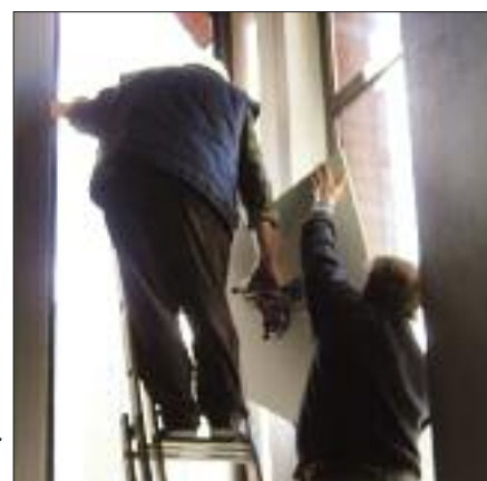
Pracownicy firmy Tiffany Glass przy wyjmowaniu okien kościoła w celu wykonania w warsztacie nowych witraży.
