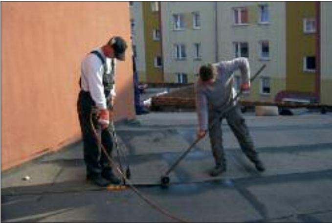
Prace dekarские na dachu zakrystii
