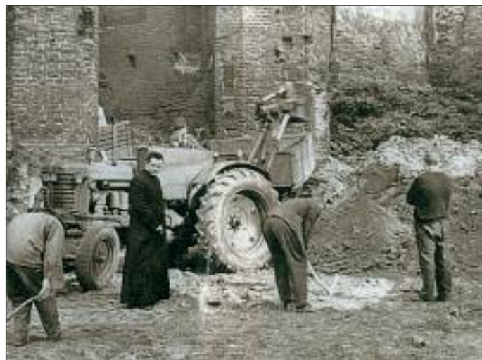
Prace przy odgruzowywaniu kościoła św. Brygidy, ok. 1970 r.
