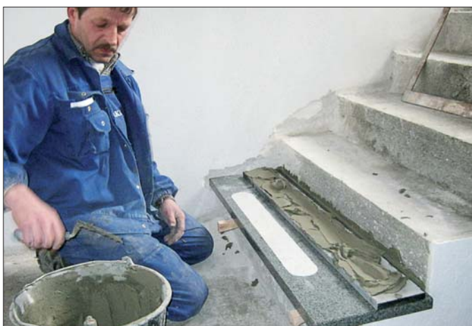
Montaż płyt granitowych na schodach prowadzących na chór
