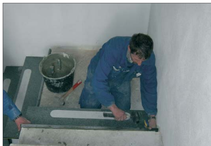
Montaż płyt granitowych na schodach prowadzących na chór
