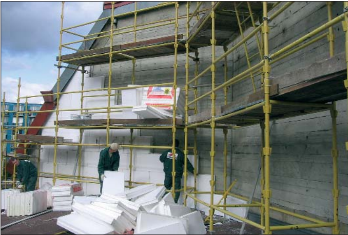
Prace przy ociepleniu wieży kościoła i ścian nad zakrystią
