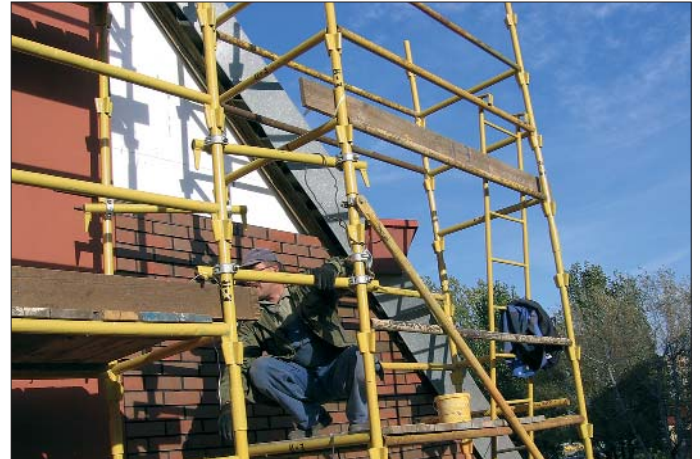
Prace przy ociepleniu wieży kościoła i ścian nad zakrystią
