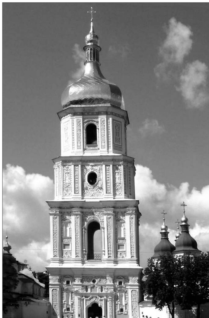
Dzwonnica przed soborem św. Zofii.
