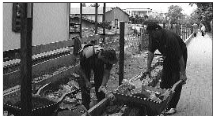
Okładanie cokołu kamieniami
