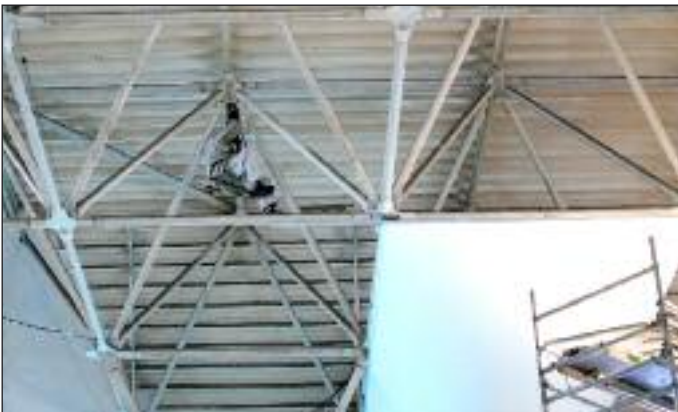
Prace inwentaryzacyjne niezbędne do wykonania dokumentacji badań nośnej konstrukcji dachowej
