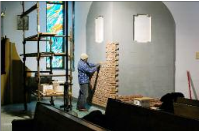
Budowanie ścianek ceglanych pod stację Drogi Krzyżowej
